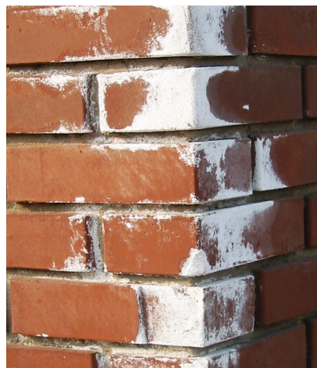
Zdjęcie 1. Białe wysolenia na cegle nie oznaczają, że jest to wapno.
