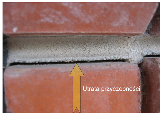
Zdjęcie 4. Stosowano domieszkę napowietrzającą.
