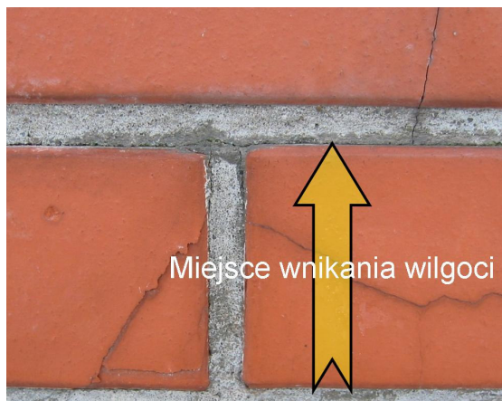
Zdjęcie 5. Postępująca degradacja muru. Widać ścieżki dostawania się wody do środka muru.
