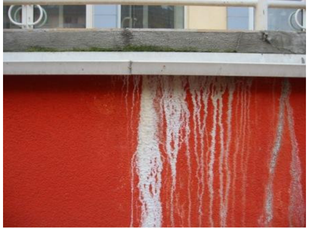
Zdjęcie 2. Betonowy podjazd. Białe naloty są pochodzenia cementowego.
